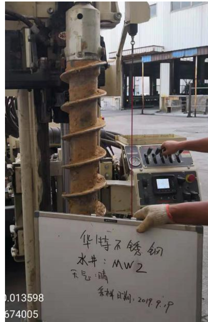
地下水采样点 MW2
