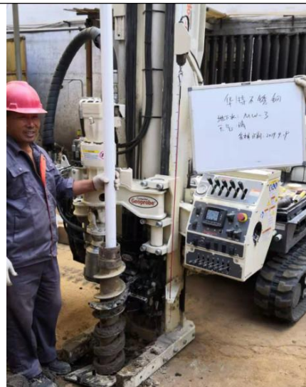
地下水采样点 MW3
